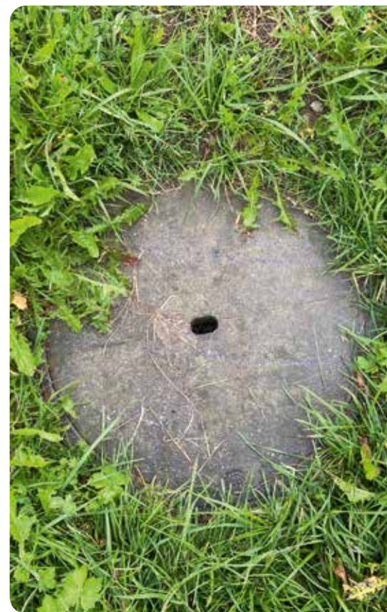
Problematischer Deckel mit offenem Pickelloch. Couvercle problématique avec trou de pic ouvert. ARENENBERG UND AFU TG
